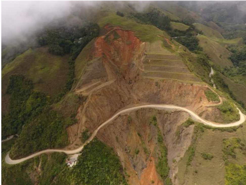
Figura 1. Sector crítico en el corredor Quibdó–Medellín entre el PR 96+560 al PR 97+110
